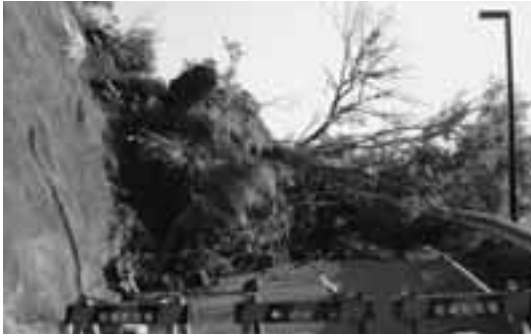
町道江奈門野線崩落状況（10月25日）
