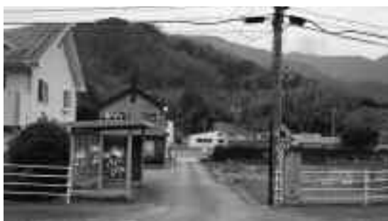
町道拡幅事業（旧中川小学校正門前）
