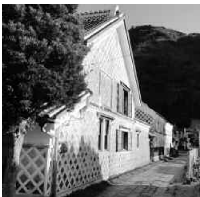
地域資源を支援する条例制定は (なまこ壁通り)
