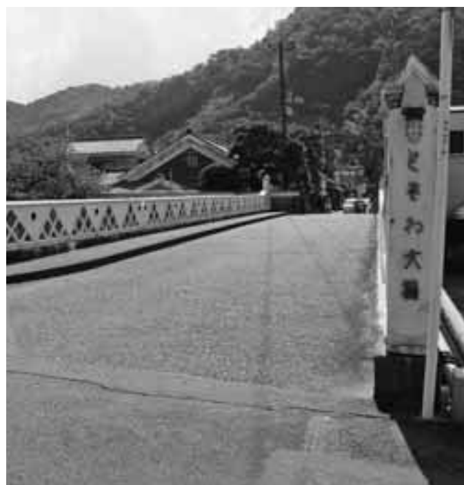
修繕が実施されるときわ大橋
