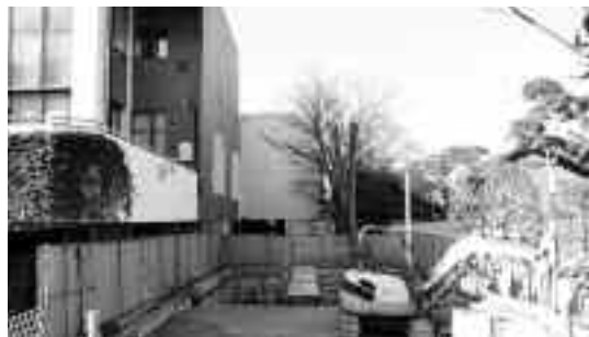
非常用発電機設置工事施工箇所（1月23日撮影）
