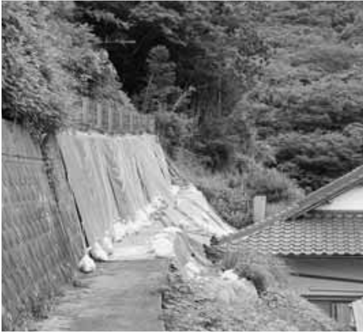
町道星山線の復旧は（岩地）
