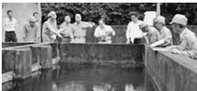
八木山浄水場
