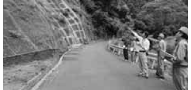
防災工事（船田）
