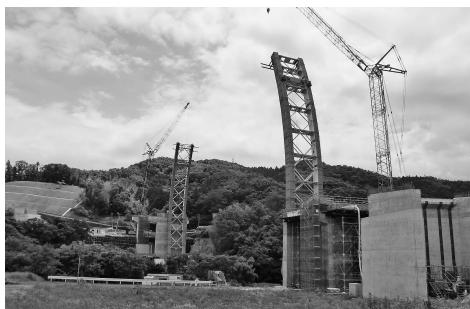
建設中の狩野川横断高架橋
