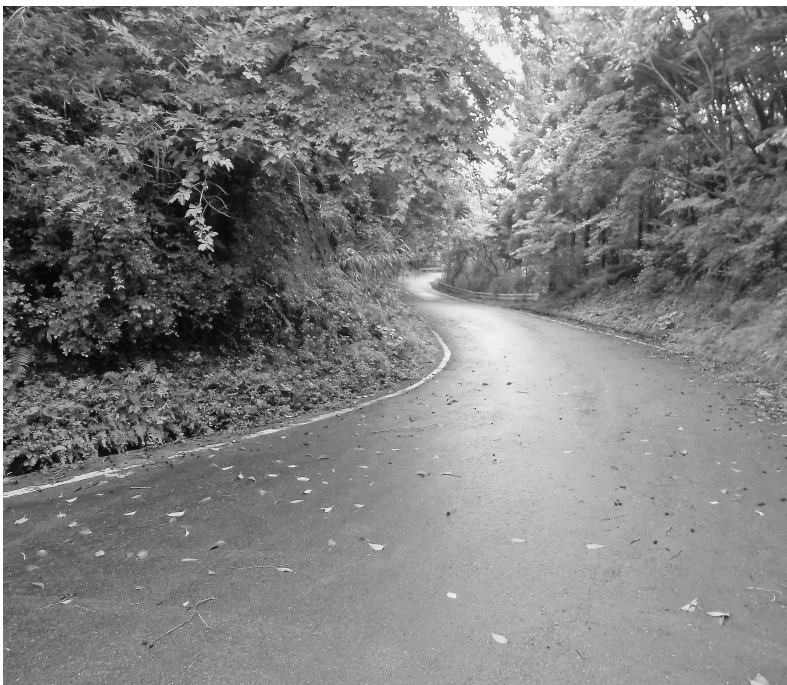
開発が中断している農道伏倉野田線
